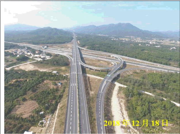
航拍黄羌枢纽互通路面及绿化现状
