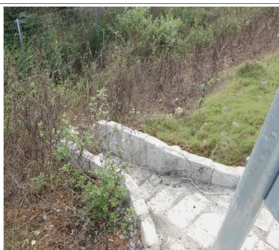
主体工程区排水沟
