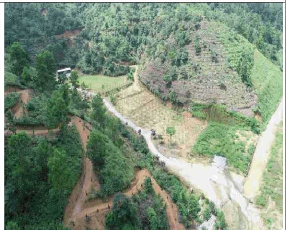
梁场已实施植被恢复
