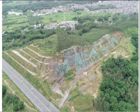
K41+360 右取土场开挖边坡实施防护措施
