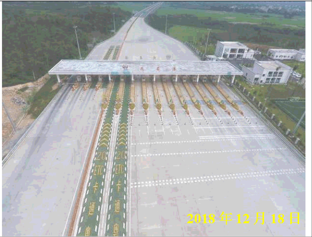
航拍茂名港收费站完成现状
