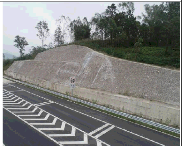
路基边坡实施浆砌石护坡
