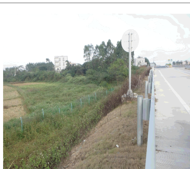
主体工程区边坡绿化
