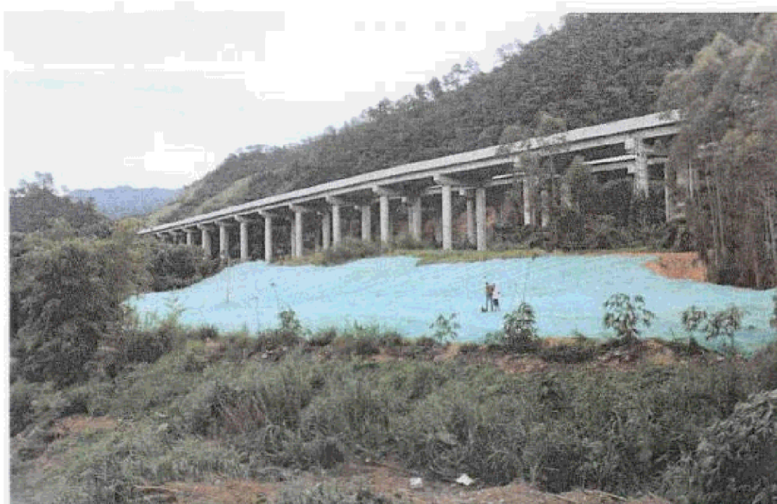
图 1-3 K9+600 右侧弃渣清运结束后的照片
