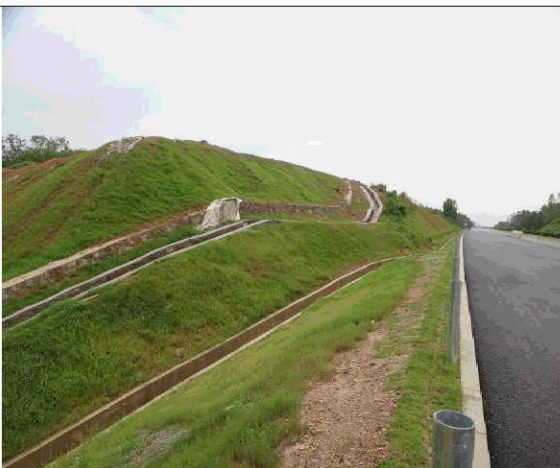
路基填方边坡急流槽
