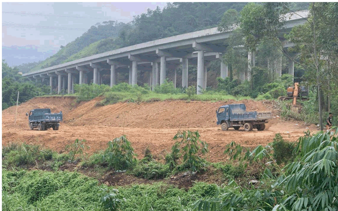
图 1-2 K9+600 右侧弃渣清运过程的照片
