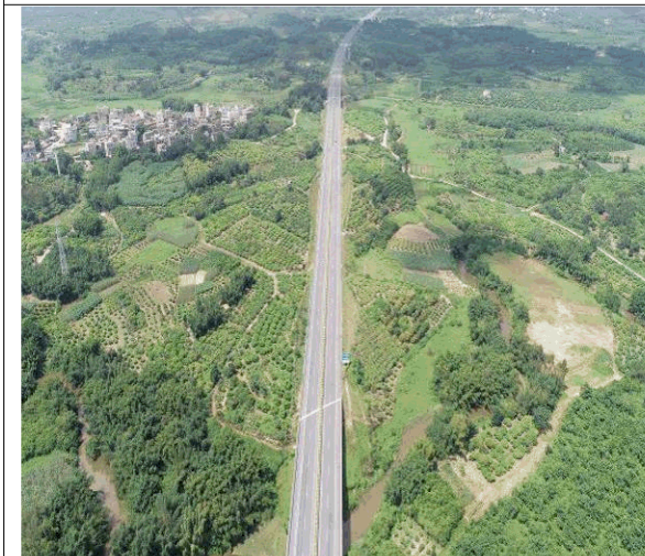
路基边坡绿化情况
