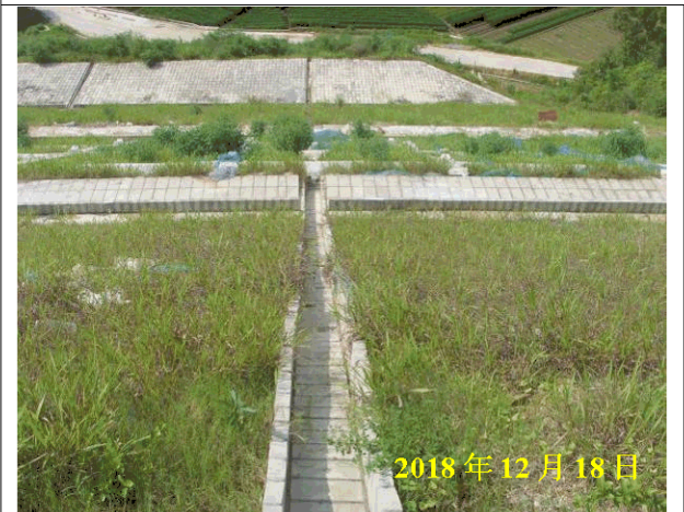
填方边坡分阶植草及排水沟防护现状
