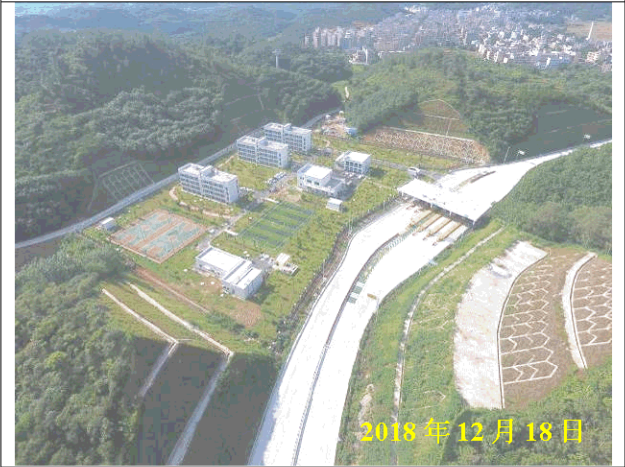
航拍那霍收费站完成现状
