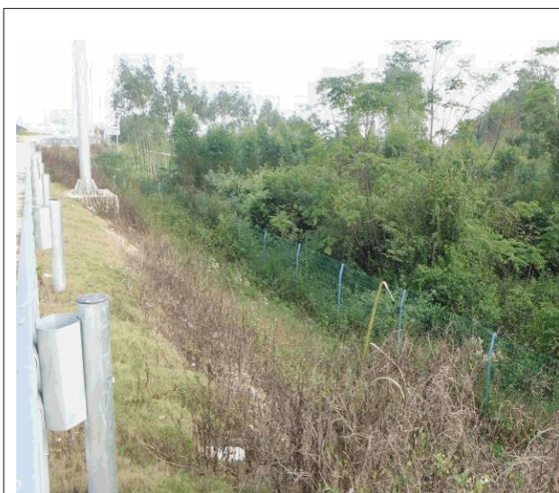
主体工程区边坡绿化
